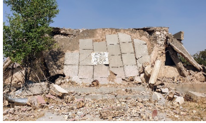
المصدر: أوتشا/ نيفيت كرافتي. مركز صحي في منطقة سليمان بيك في صلاح الدين (25 حزيران 2019)
